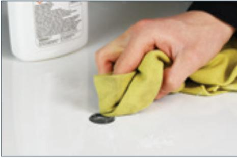
5. Reinigen Sie die Fläche, an der die Antenne montiert wird, und vergewissern Sie sich, dass sie schmutz- und fettfrei ist.
